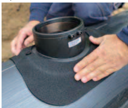
Covorașul de cauciuc autoadeziv de pe ASA VL d160 etanșează șaua pe țeavă.
